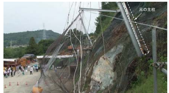
写真5 支柱の支持岩盤の破壊
