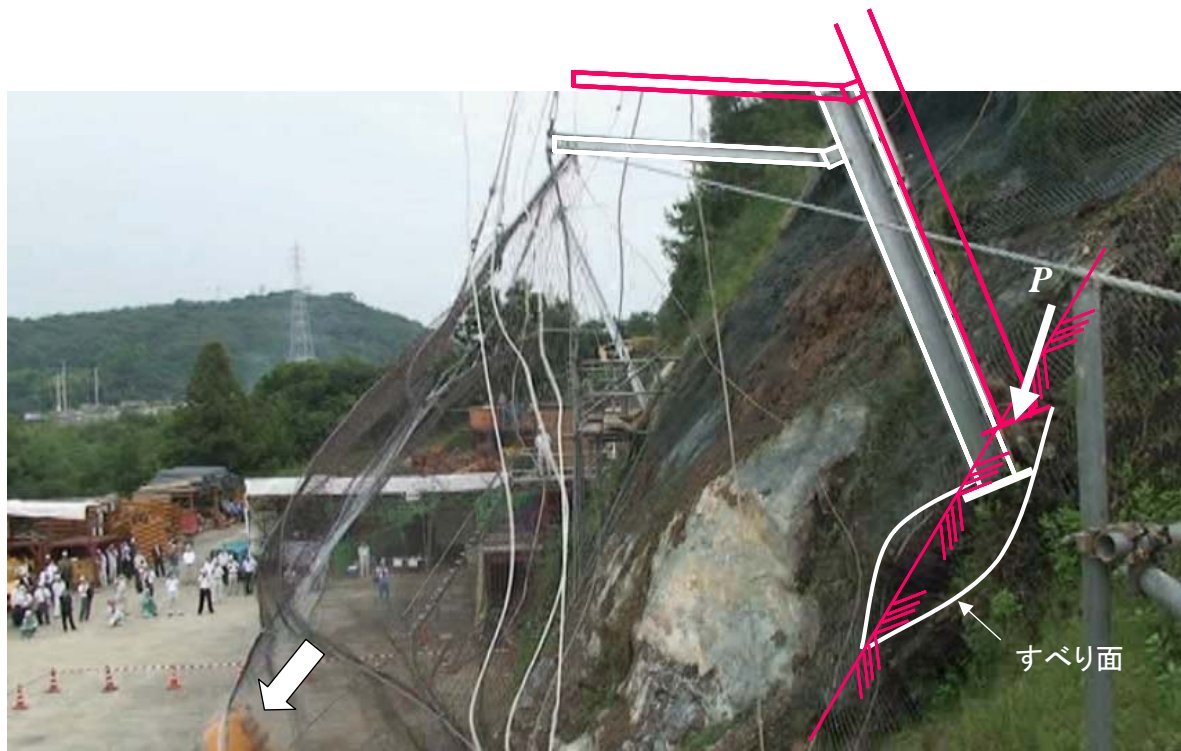
写真 12 右側支柱の沈下
