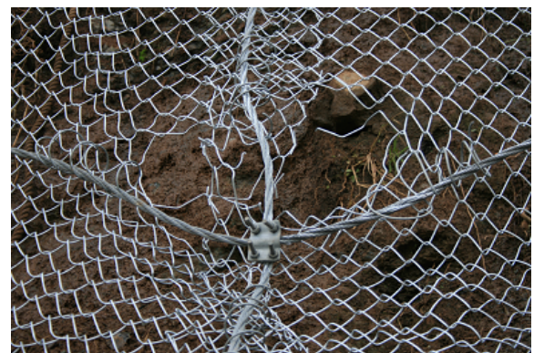
写真4 金網の破損
