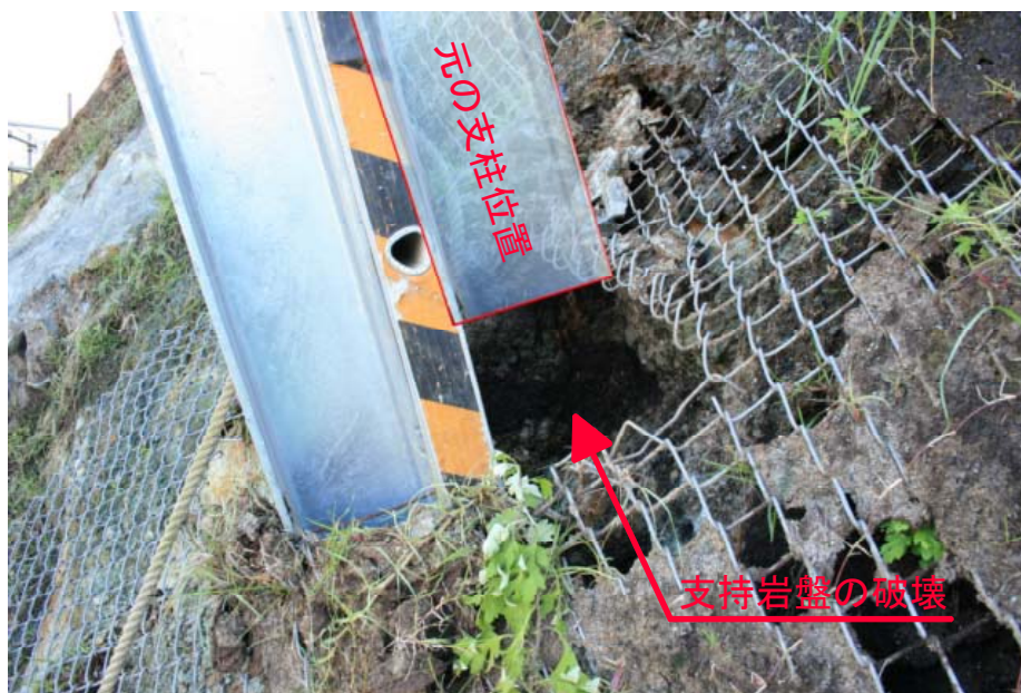
写真 12 支柱の支持岩盤の破壊
