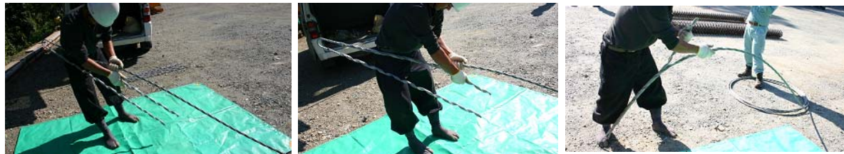
写真10 ワイヤーロープに巻付けグリップを取り付ける様子
