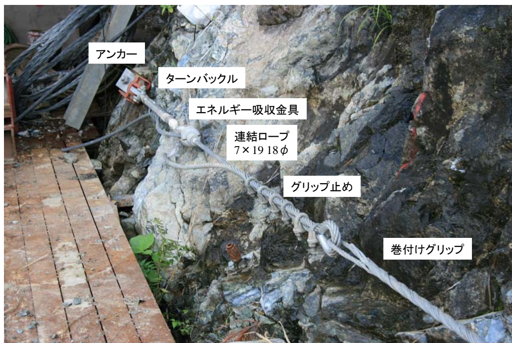
写真6 7 \times 19 \phi 18 と 3 \times 7 \phi 18 の2種類のワイヤーロープの連結
