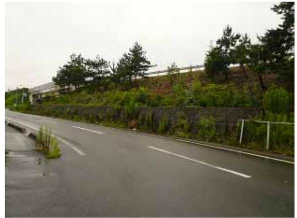
写真 - 20 北陸自動車道のブロック積み擁壁
