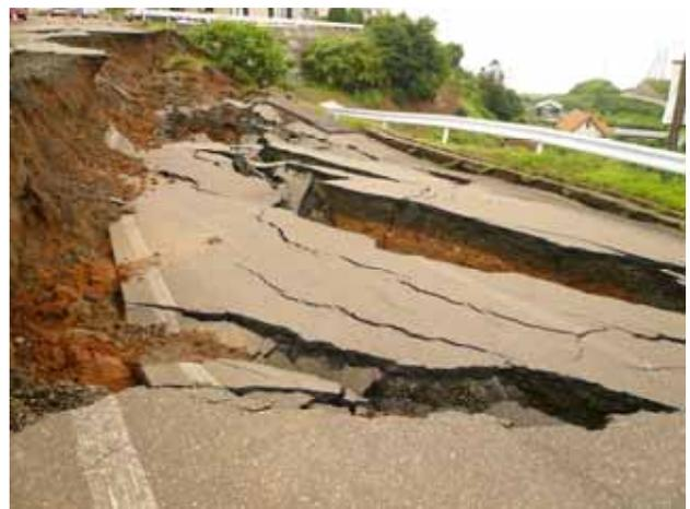
写真 - 33 路面の陥没
