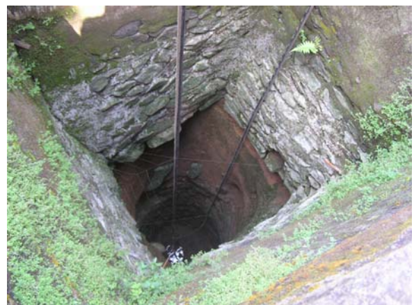
写真-3 地震により枯渇した井戸
