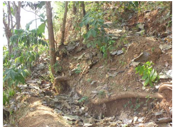
写真-2 斜面崩壊上部の亀裂・段差状況
