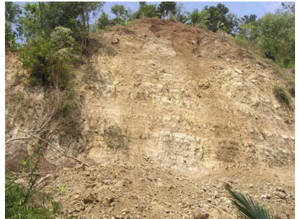
写真-1 地震により発生した斜面崩壊
