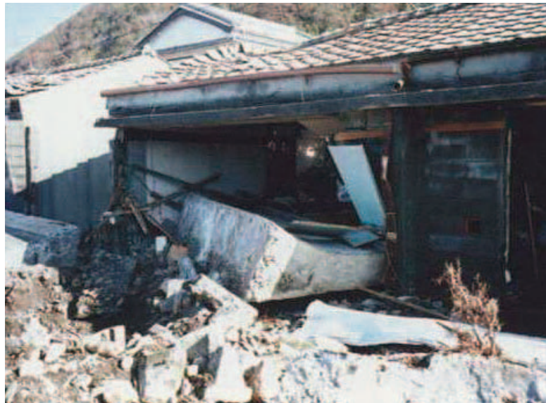
▲民家に飛び込んだ堤防 (菜生海岸) (提供：高知県)
