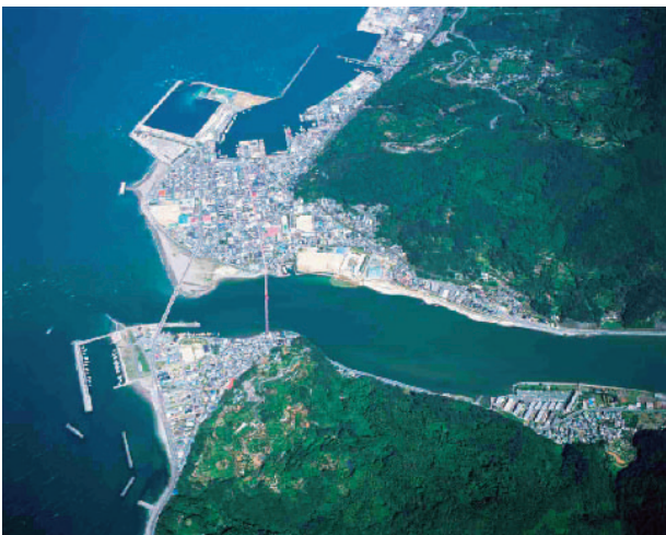
▲昭和南海地震で浸水した肱川河口部 (大洲市長浜町)
