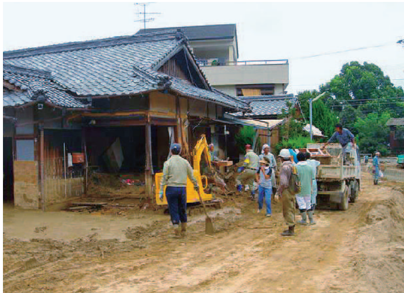
▲ボランティアによる復旧作業
