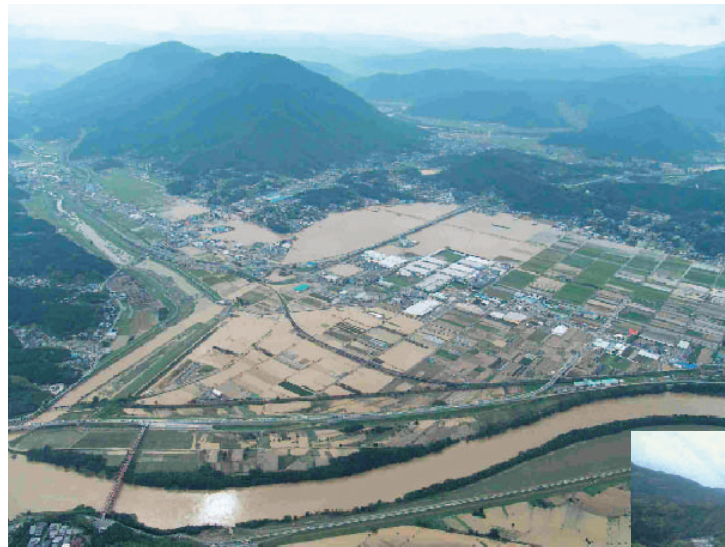
▲平成16年の洪水による浸水状況 (大洲市東大洲)
