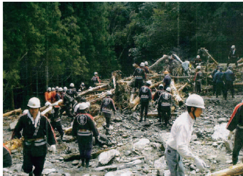
▲消防団による復旧作業 (提供：西条市)
