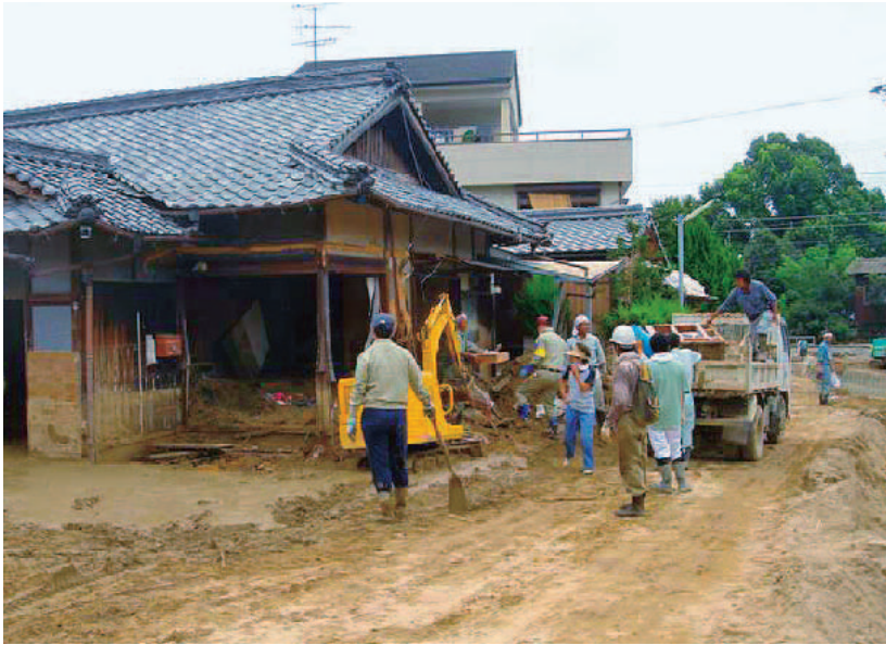
▲ボランティアによる復旧作業
