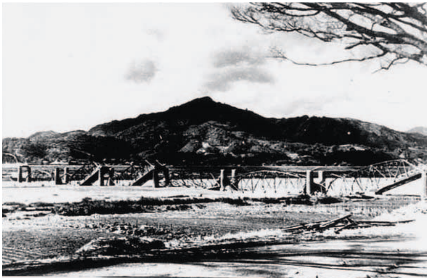
▲南海地震で落橋した渡川鉄橋 (提供: 四万十市)
